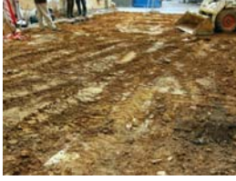
72) Protecció estructures amb terra
