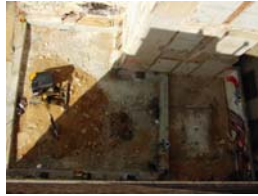
PIC01524 Vista general inici segona fase
