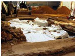
51) Protecció amb geotèxtil
