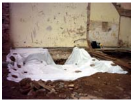
83) Cobriment estructures Sector 1
