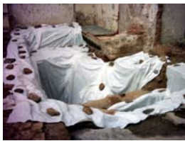
84) Cobriment estructures Sector 1
