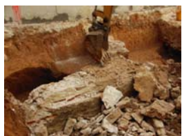
PIC01748 Àmbits 3 i 2 Afectació mur u.e. 1117
