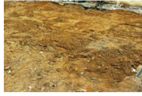
74) Protecció estructures amb terra
