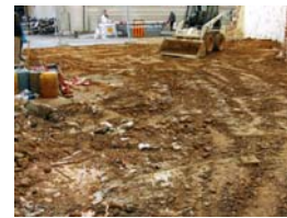
86) Cobriment estructures Sector 1
