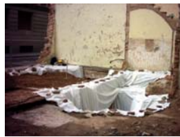
85) Cobriment estructures Sector 1
