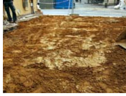
73) Protecció estructures amb terra
