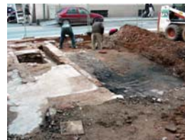
29) Excavació Zona 2 Espai 1
