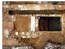
63) Vista general Zona 1 Espai 2
