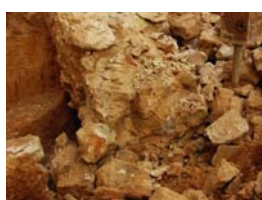
PIC01754 Afectació mur u.e. 1144
