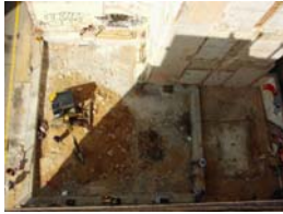
PIC01522 Vista aerea inici segona fase
