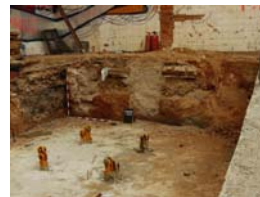
PIC01540 Sector 3 Estat del sector a l'inici
