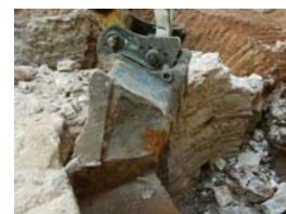
PIC01747 Àmbit 3 Afectació Pou u.e. 1137
