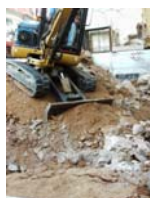
PIC01742 Afectació estructures
