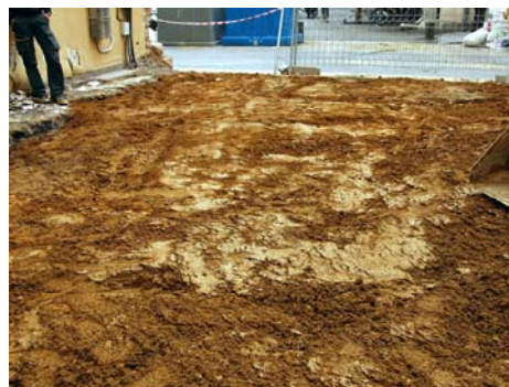
Protecció de les estructures amb geotèxtil i una capa de terres
