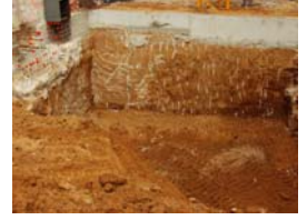
PIC01814 Rebaix final obra
