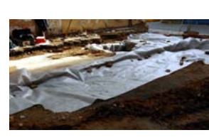
70) Protecció estructures amb geotèxtil
