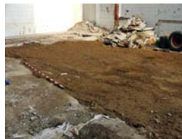
52) Protecció amb geotèxtil i terra
