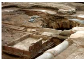
27) Detall final àmbit dipòsits
