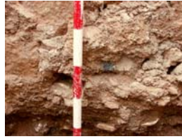
PIC01705 Detall mur u.e. 1144
