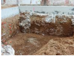
PIC01811 Àmbit 3 Afectació d'estructures
