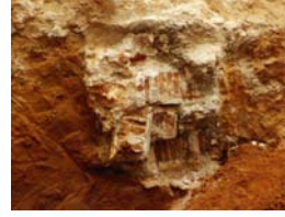
PIC01813 Afectació mur u.e. 1144
