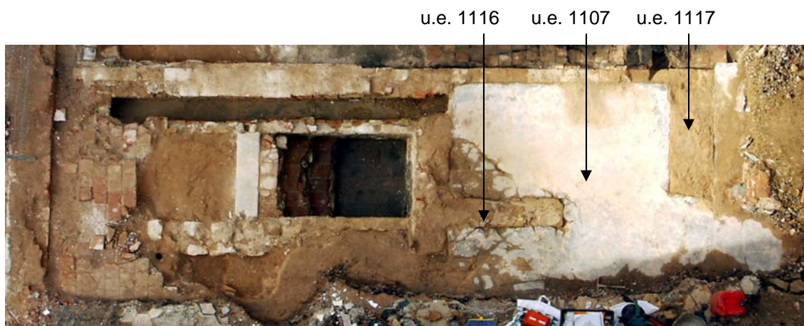
Vista aèria on s'observen l'espai 1 amb l'accés des del carrer; l'espai 2 amb l'hipogeu i l'espai 3 compartimentat
