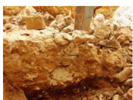
PIC01753 Afectació cisterna u.e. 1077
