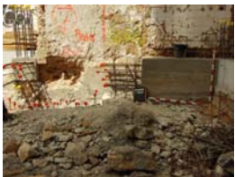
PIC01537 Sector 3 Estat del sector a l'inici
