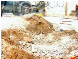
PIC01543 Sector 1 Afectació del reompliment de l'obra
