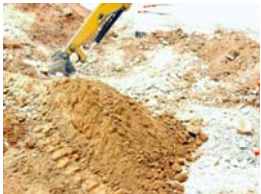
PIC01542 Sector 1 Afectació del reompliment de l'obra
