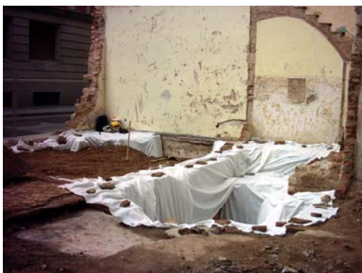
Les estructures protegides amb geotèxtil i la capa de sorres pel seu rebliment provisional
