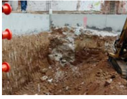
PIC01794 Rebaix obra
