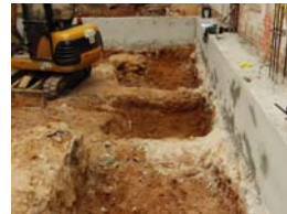
PIC01545 Sector 2 primeres estructures
