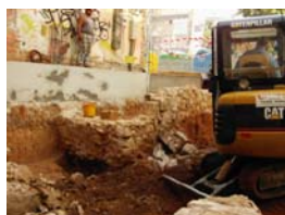
PIC01749 Vista mur u.e. 1144
