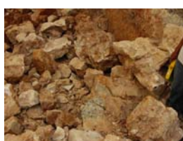
PIC01755 Afectació mur u.e. 1144
