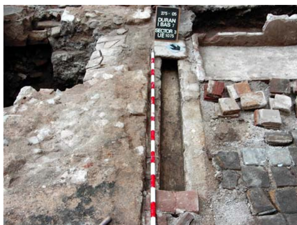
Vista de la claveguera u.e. 1075 i un cop afectada la tapa i excavat el seu rebliment
