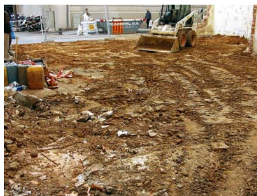
Les estructures protegides amb geotèxtil i la capa de sorres pel seu rebliment provisional
