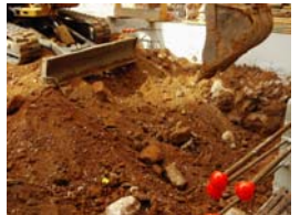
PIC01591 Sector 2 Rebaix mecànic
