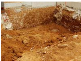
PIC01815 Rebaix final obra
