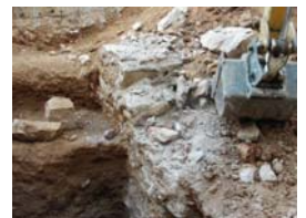
PIC01740 Afectació estructures
