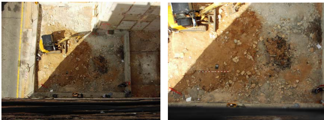
Vista general i de detall del Sector 2 a l'inici de la Segona Fase
