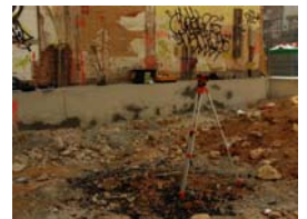
PIC01541 Sector 2 Estat del sector a l'inici
