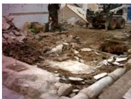
16) Afectació paviments contemporanis
