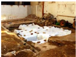
50) Cobriment estructures amb geotèxtil
