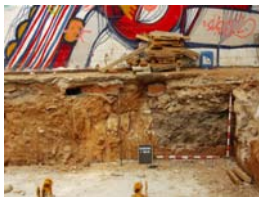
PIC01538 Sector 3 Estat del sector a l'inici
