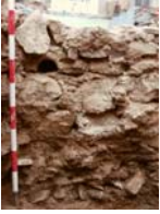
PIC01708 Detall alçat mur u.e. 1100 amb desguàs u....
