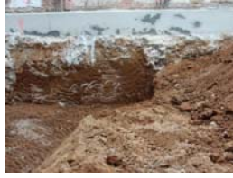
PIC01812 Àmbit 2 Afectació d'estructures
