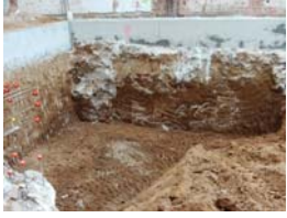
PIC01810 Àmbit 3 Afectació d'estructures
