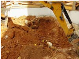
PIC01592 Sector 2 Rebaix mecànic
