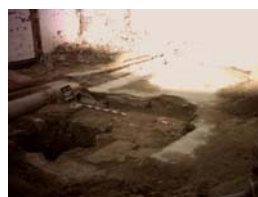
13) Vista general àmbit cisterna
