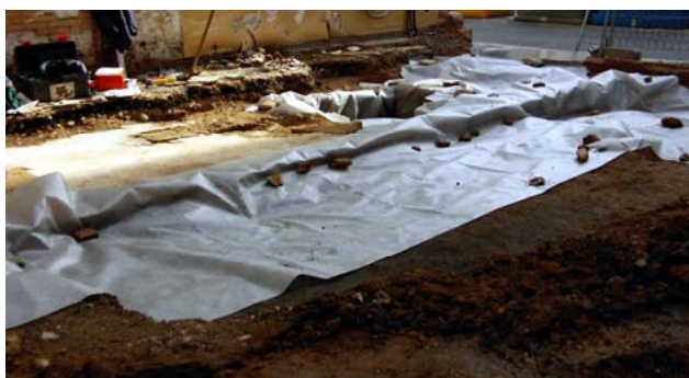
Protecció de les estructures amb geotèxtil i una capa de terres
